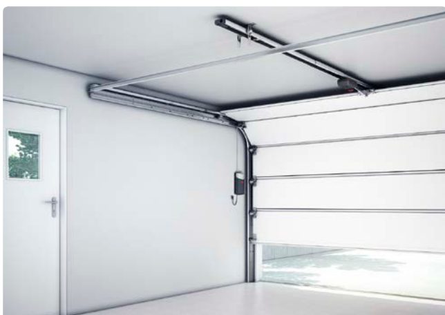
Монтаж возле ворот
